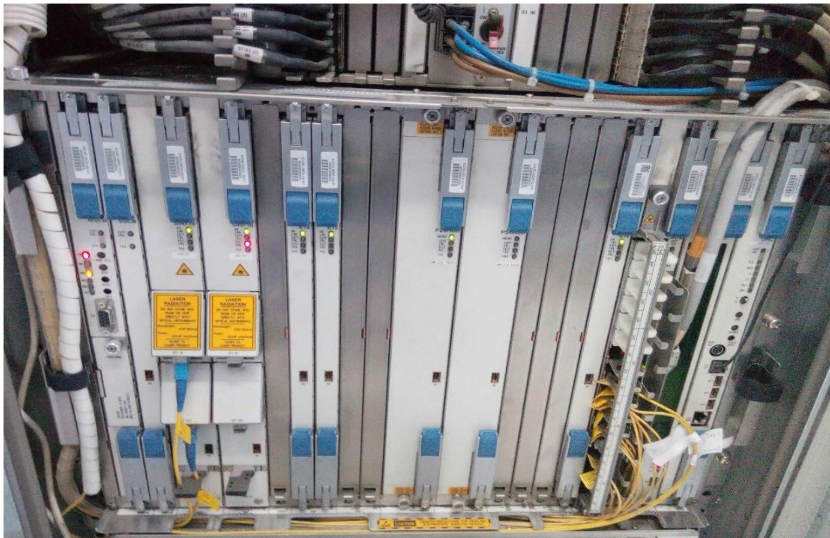
Рисунок 2 - Оборудование U – Node WDM на предприятии связи
