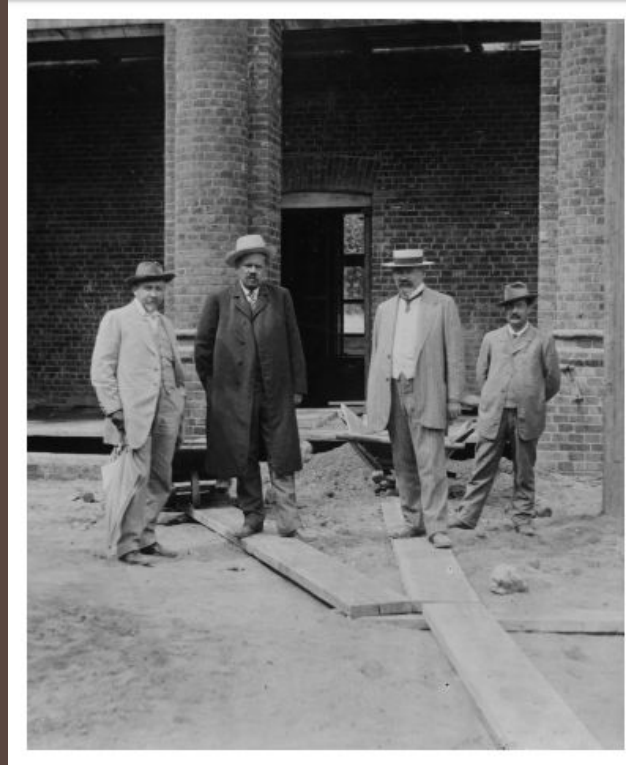
Строительство аудиторного корпуса Чаплыгин С. А. второй слева
