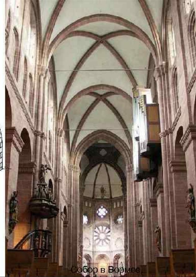
Свод (от «сводить» — соединять, смыкать) — в архитектуре тип перекрытия или покрытия пространства (помещения), ограниченного стенами, балками или столбами — конструкция, которая образуется наклонными поверхностями (прямолинейными или криволинейными).
