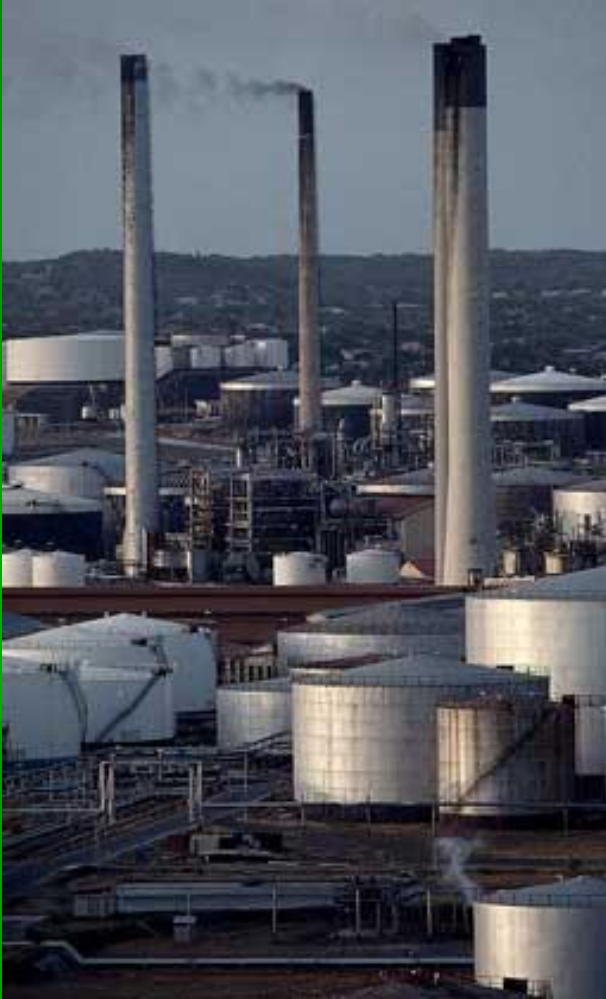
Завод по переработке нефти.
