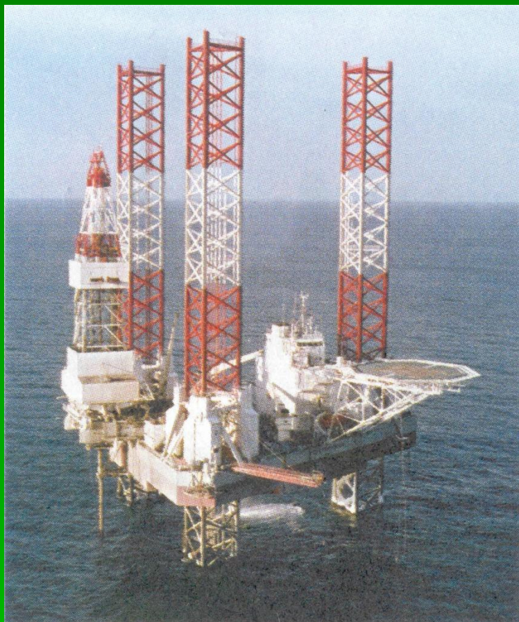
Плавучая бурильная установка на шельфе Охотского моря
