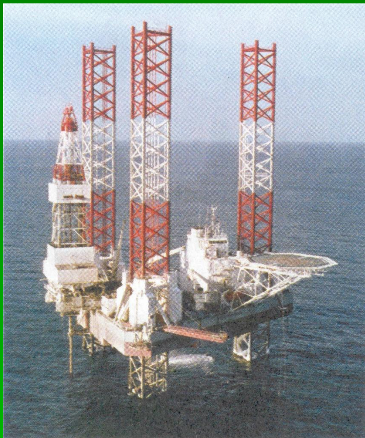
Плавучая бурильная установка на шельфе Охотского моря
