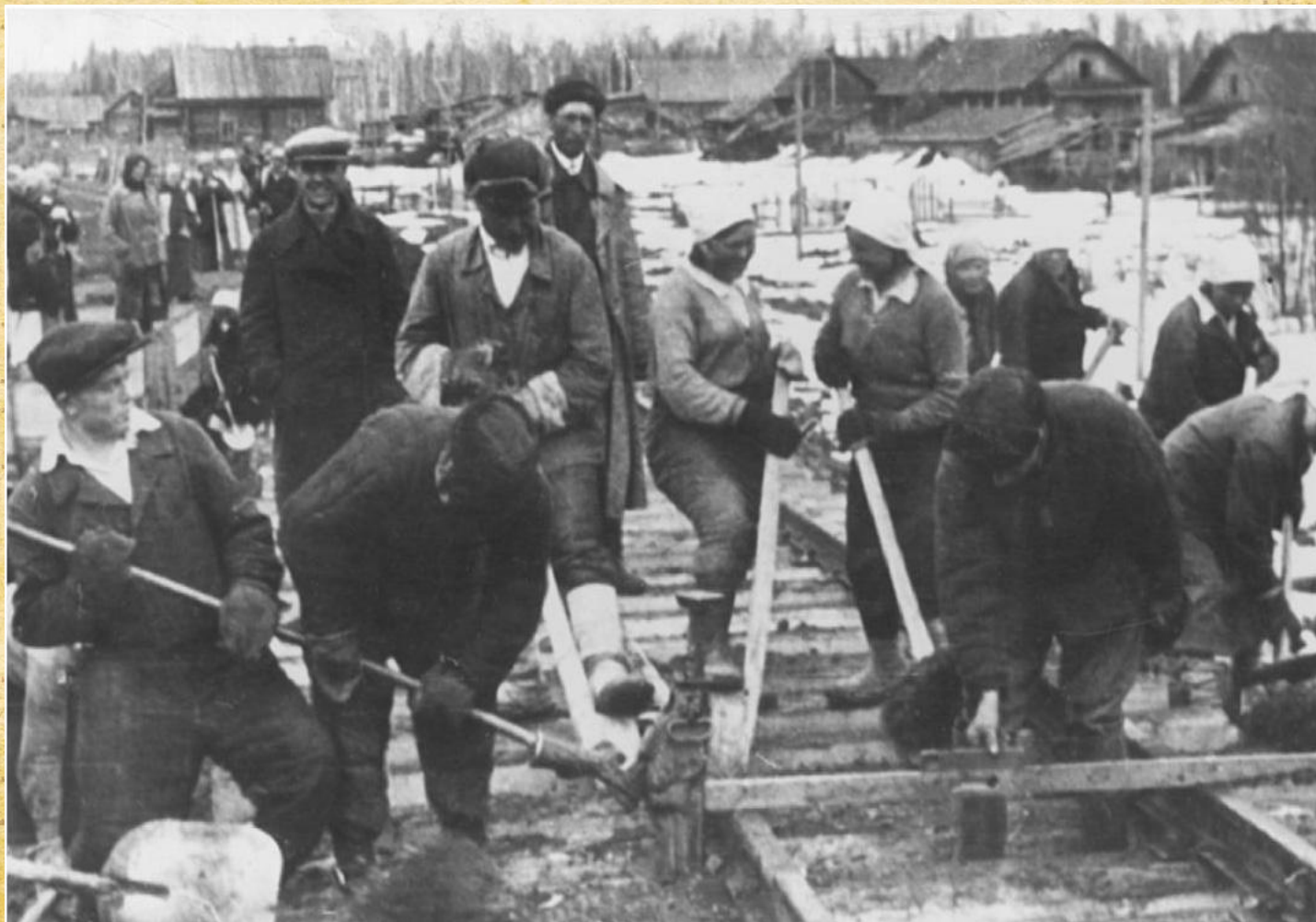
Укладка рельсов на одном из участков железной дороги Ижевск-Балезино, 1943 год
