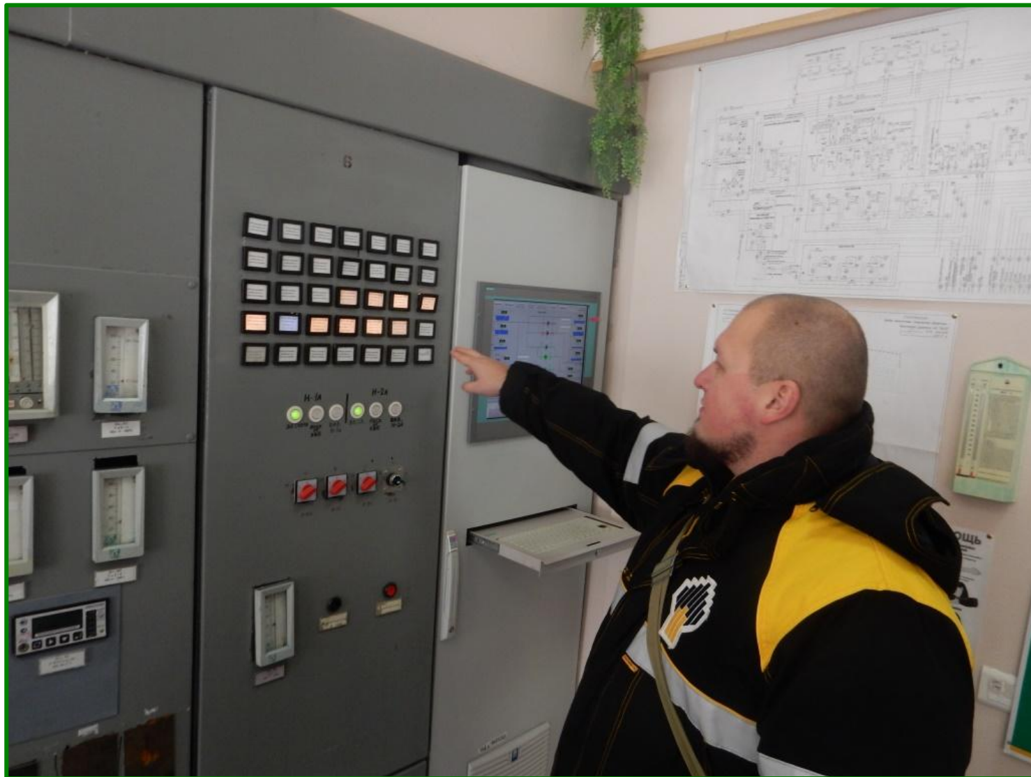
ФОТО № 5. Центральное реагентное хозяйство, цех №17 Системы блокировок, сигнализации и противоаварийной защиты исправны и включены в работу.
