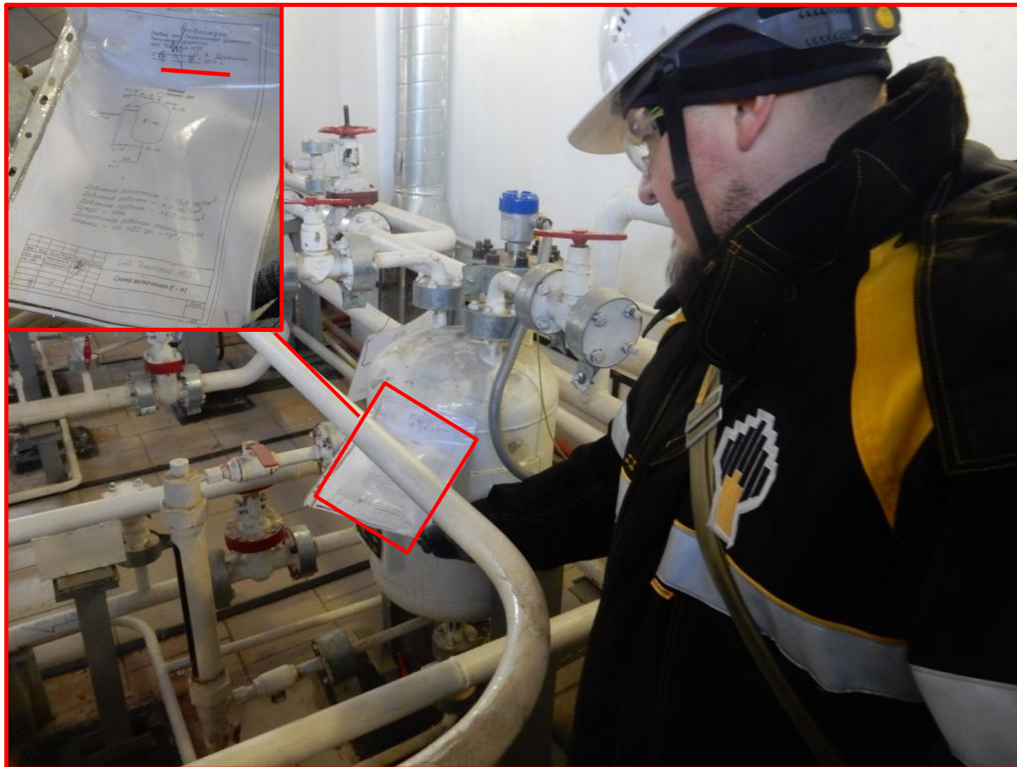
ФОТО № 21. Центральное реагентное хозяйство, цех №17 Не актуализирована схема подключения E-41.
