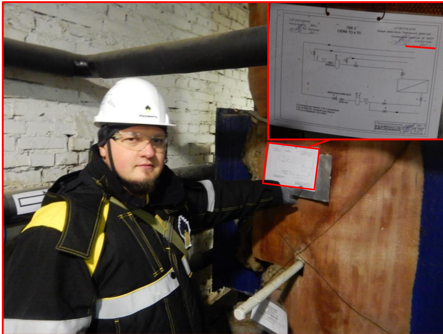
ФОТО № 20. Центральное реагентное хозяйство, цех №17 Не актуализирована принципиальная схема ПВК-3.
