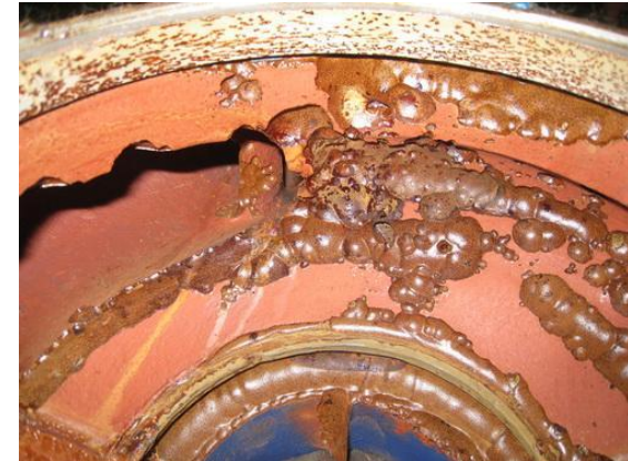
Кавитационная эрозия поверхности улитки насоса
