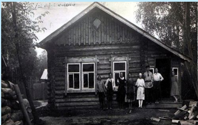
Здание школы ХОД - красильная мастерская.
