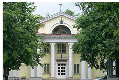
Научно-технический информационный центр (Дом учёных ЦАГИ)
