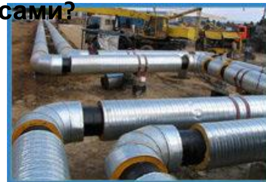
монтаж компенсаторов
