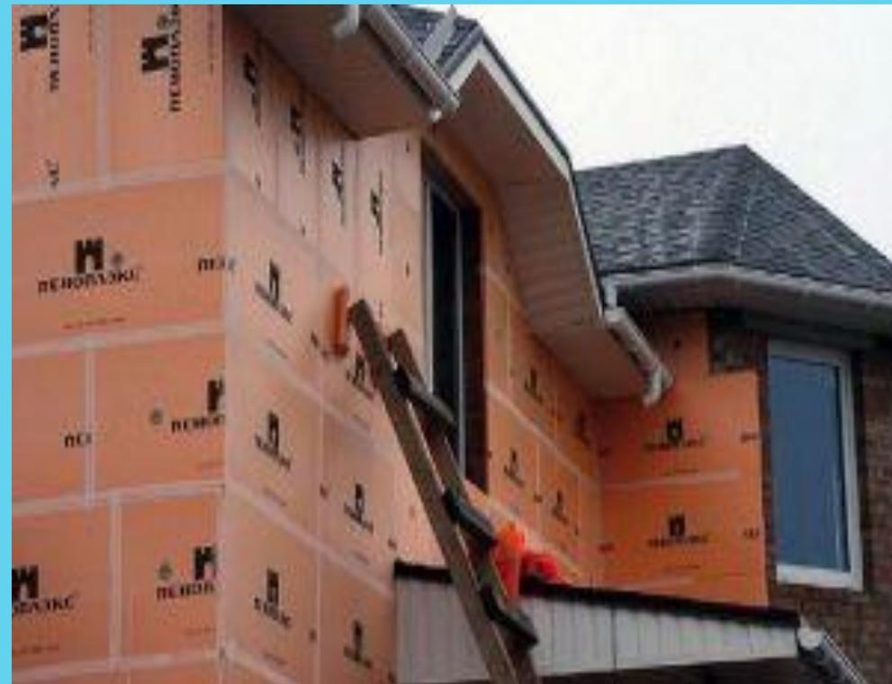
Утепление домов экструзионным пенополистиролом
