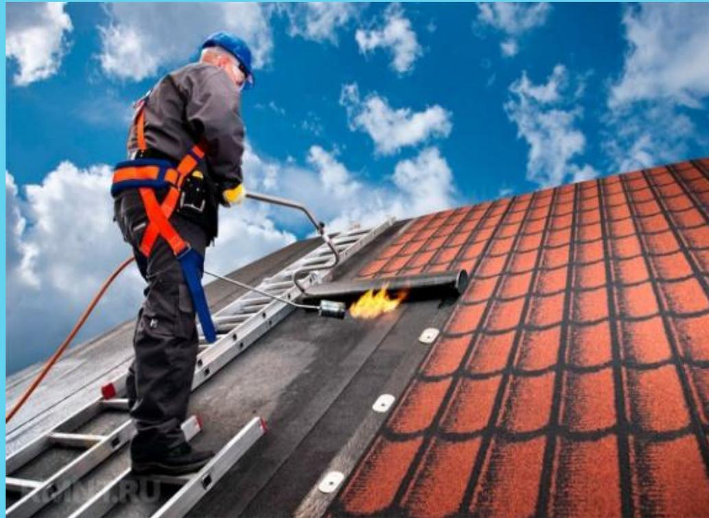
РУЛОННЫЕ ГИДРОИЗОЛЯЦИОННЫЕ МАТЕРИАЛЫ
