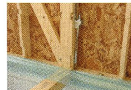
Металлический крепеж колонны
