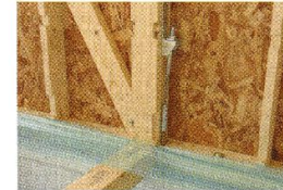
Металлический крепеж колонны
