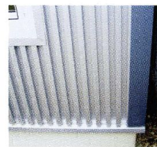
Облицовка из листовой стали с открытыми стыками
