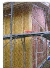
Метод теплоизоляции для внешних стен в 200 мм, позволяющих обеспечить значение Q не превышающее  $1,6 \text{ Вт}/\text{м}^2 \times \text{К}$ .
