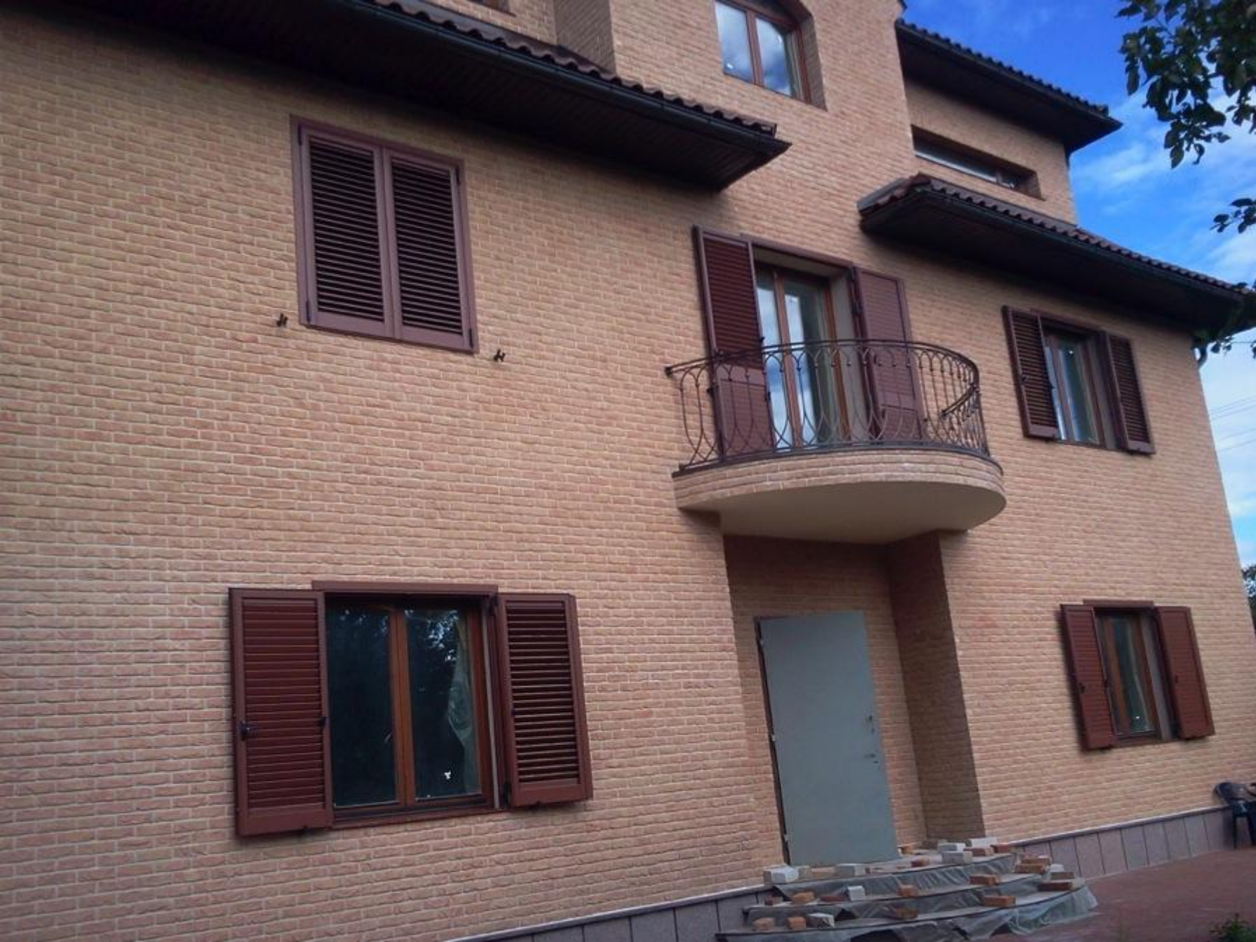
Объект под Киевом
