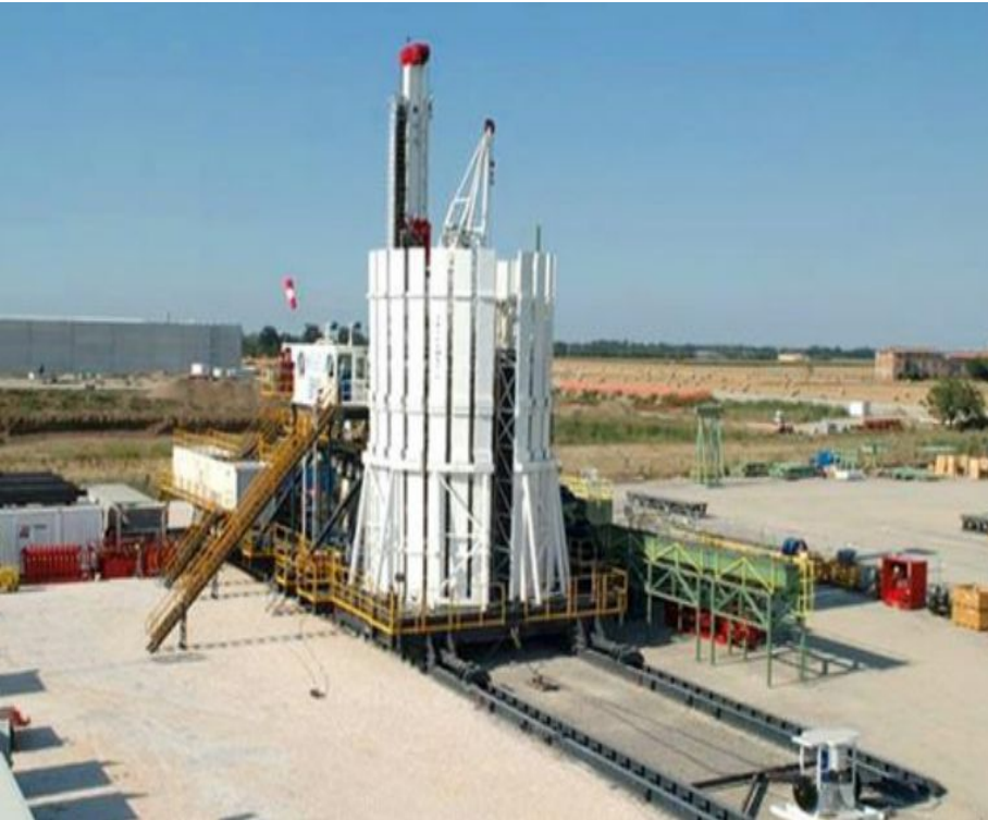
Автоматизированная буровая установка гидравлического типа NN-300
