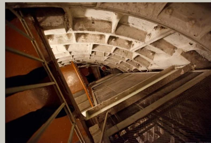
Вертикальный ствол-шахта — точная копия тоннеля метро, прорытого вертикально
