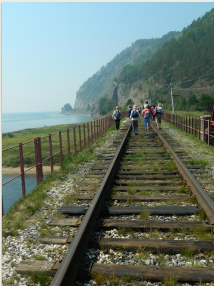
Мост на КБЖД
