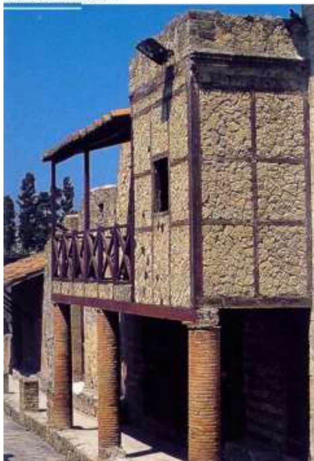
Геркуланум. Район аристократической застройки Дом с каркасом
