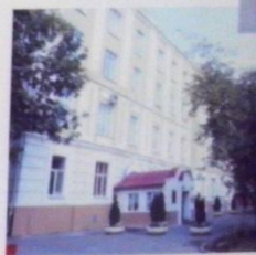
В сентябре 2002 г. был проведен современный ремонт в здании, который по началу и закончен в апреле.
