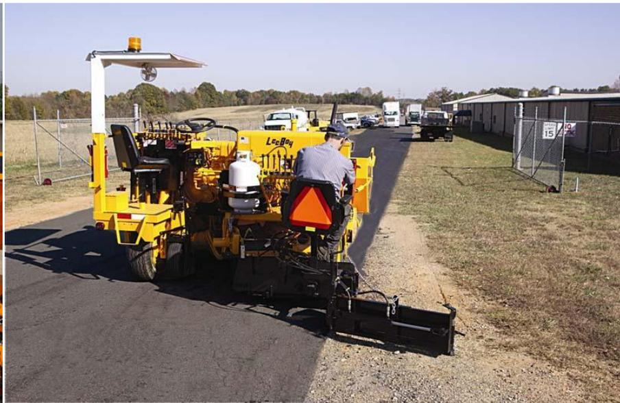
8. После устройства дорожной одежды на уширении **перекрывают всю проезжую часть, включая существующую дорожную одежду, слоем асфальтобетона** с таким расчетом, чтобы продольный стык на нем не совпадал (в плане) с точками сопряжения существующей и уширяемой дорожных одежд.
