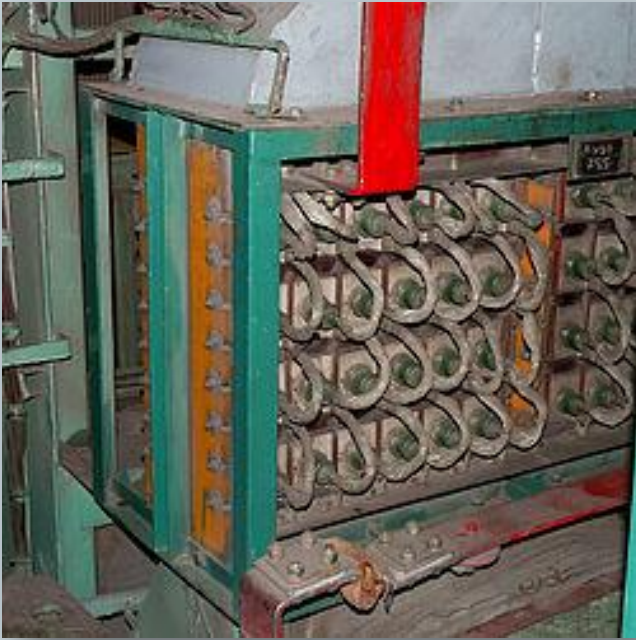
Диодный выпрямитель, построенный по схеме моста
