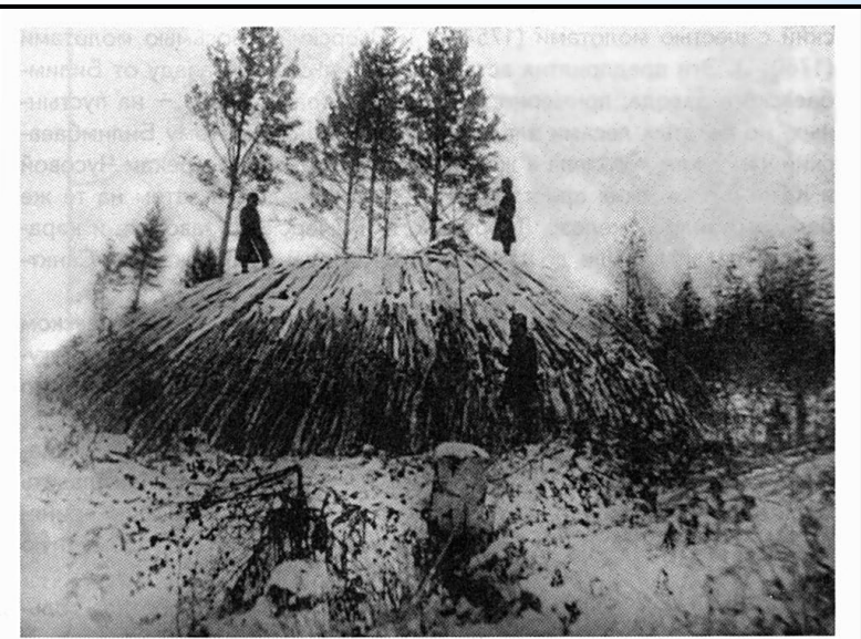
Получение древесного угля в лесной даче Билимбаевского завода, 1899 г. С фотографии Н.А.Тунева.
