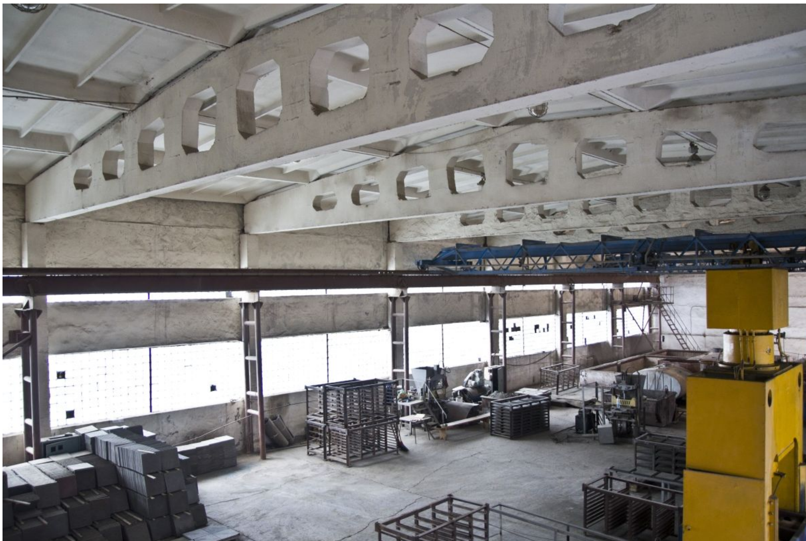
Стропильная балка с решетчатой стенкой
