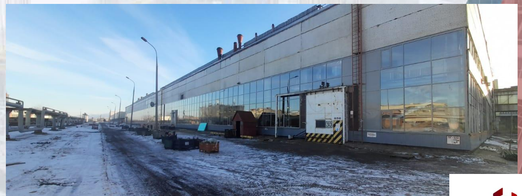
Остекление корпуса 04 АО «АВТОВАЗ» г. Тольятти
