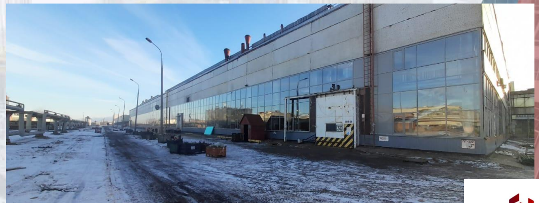
Остекление корпуса 04 АО «АВТОВАЗ» г. Тольятти
