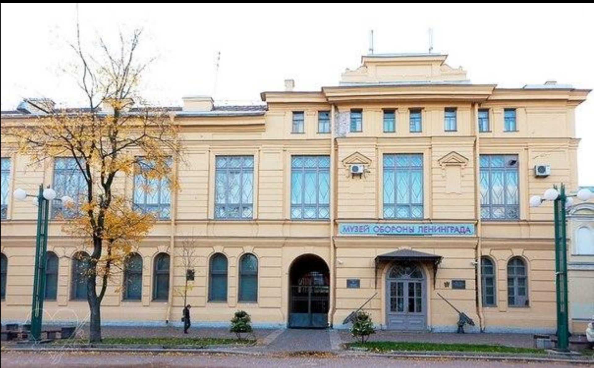
Здание Кустарного музея в Соляном переулке. Архитектор Петр Трифанов. 1901-1903 гг.
