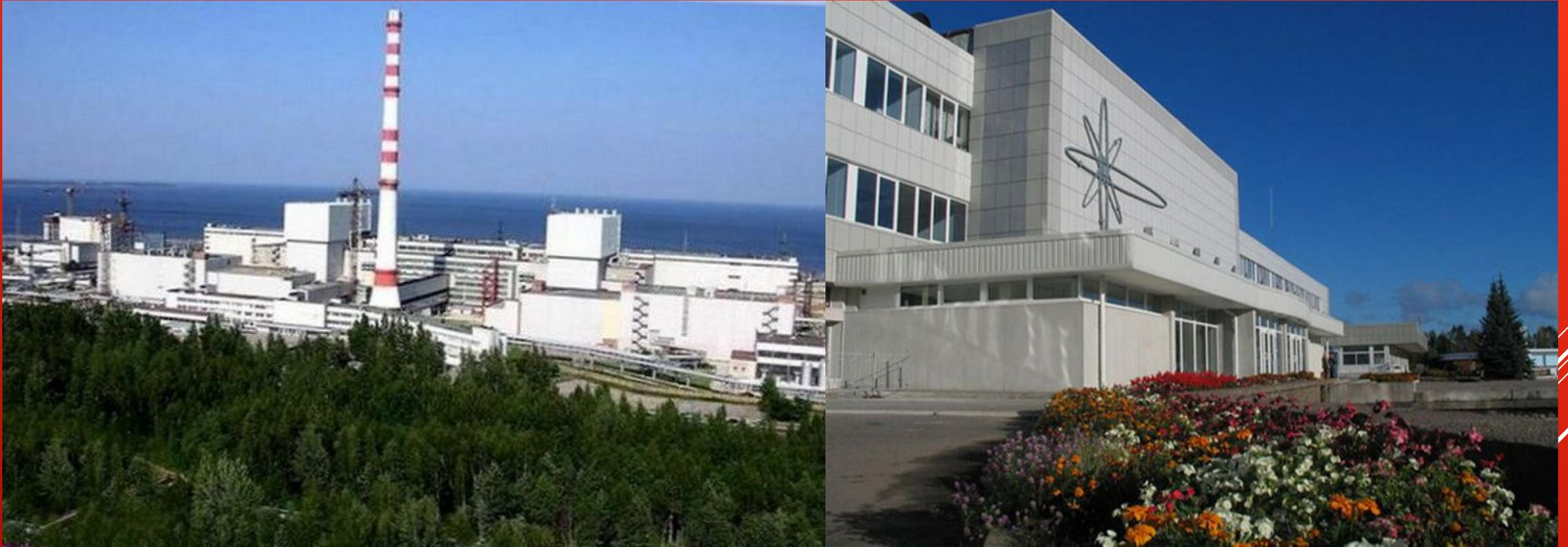
Первая в стране станции с реакторами типа РБМК-1000 (реактор большой мощности канальный). Включает в себя четыре энергоблока. Ресурсы для каждого из четырех энергоблоков продлены на 15 лет : 1-го энергоблока - до 2018 года, 2-го энергоблока - до 2020 года, 3-го и 4-го энергоблоков - до 2025 года
