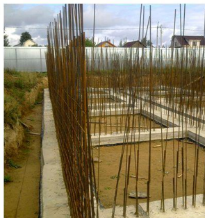
Армирование в монолитном строительстве
