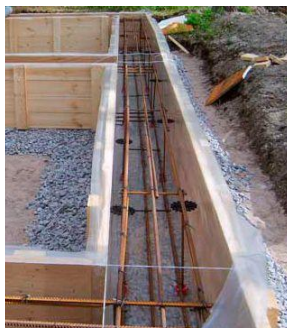
Армирование при заливке
