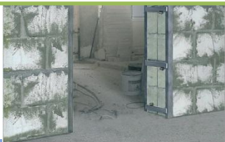
Для укрепления дверных проемов
