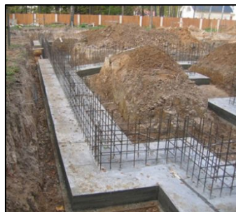
Армирование в монолитном строительстве
