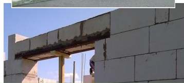
Для укрепления оконных проёмов
