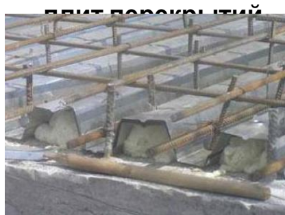
Армирование при заливке
