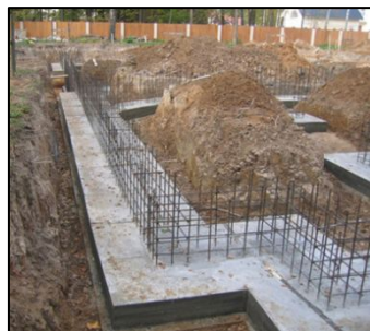
Армирование в монолитном строительстве
