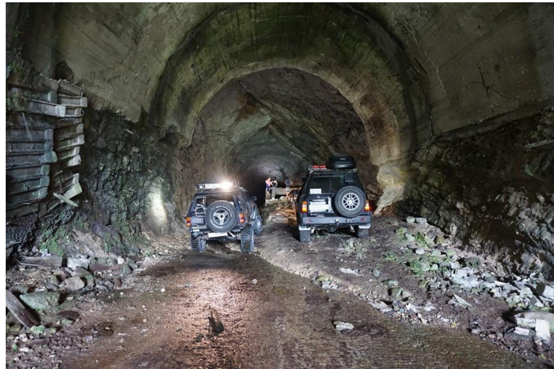
Деривационный туннель ИГЭС
