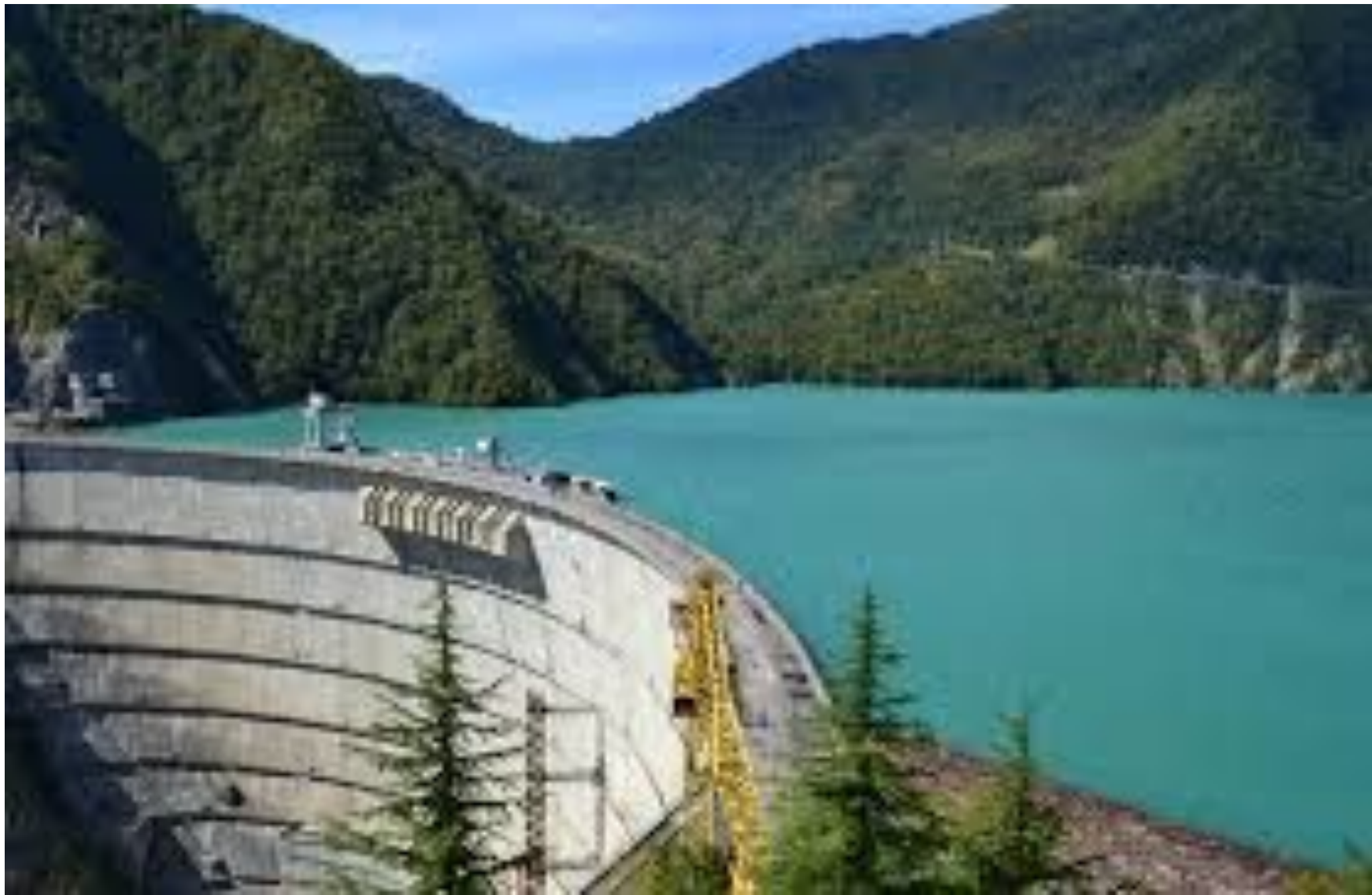
Плотина Ингури ГЭС
