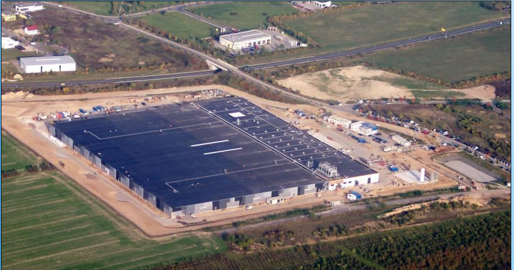
Erste Solarfabrik von First Solar im Bau ...
