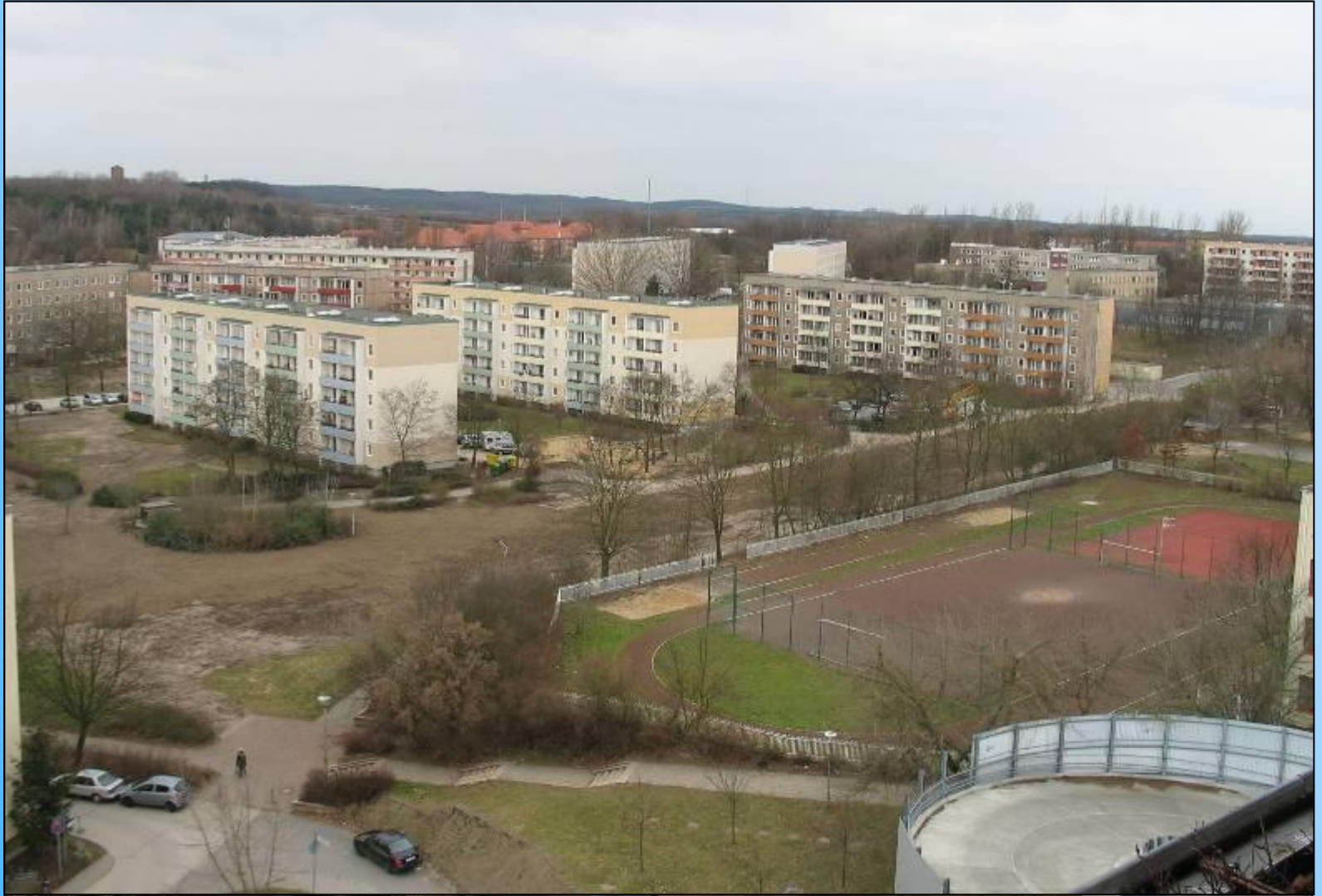
Rückbau von Plattenbauten im Stadtgebiet Süd
