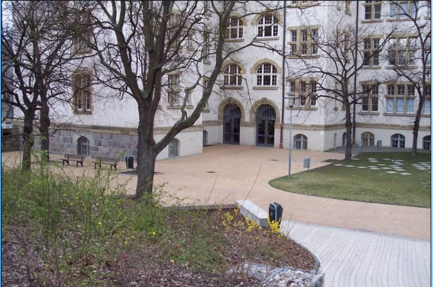
Aufwertung der Stadtteile : Sanierung Wicke-Gymnasium im Zentrum
