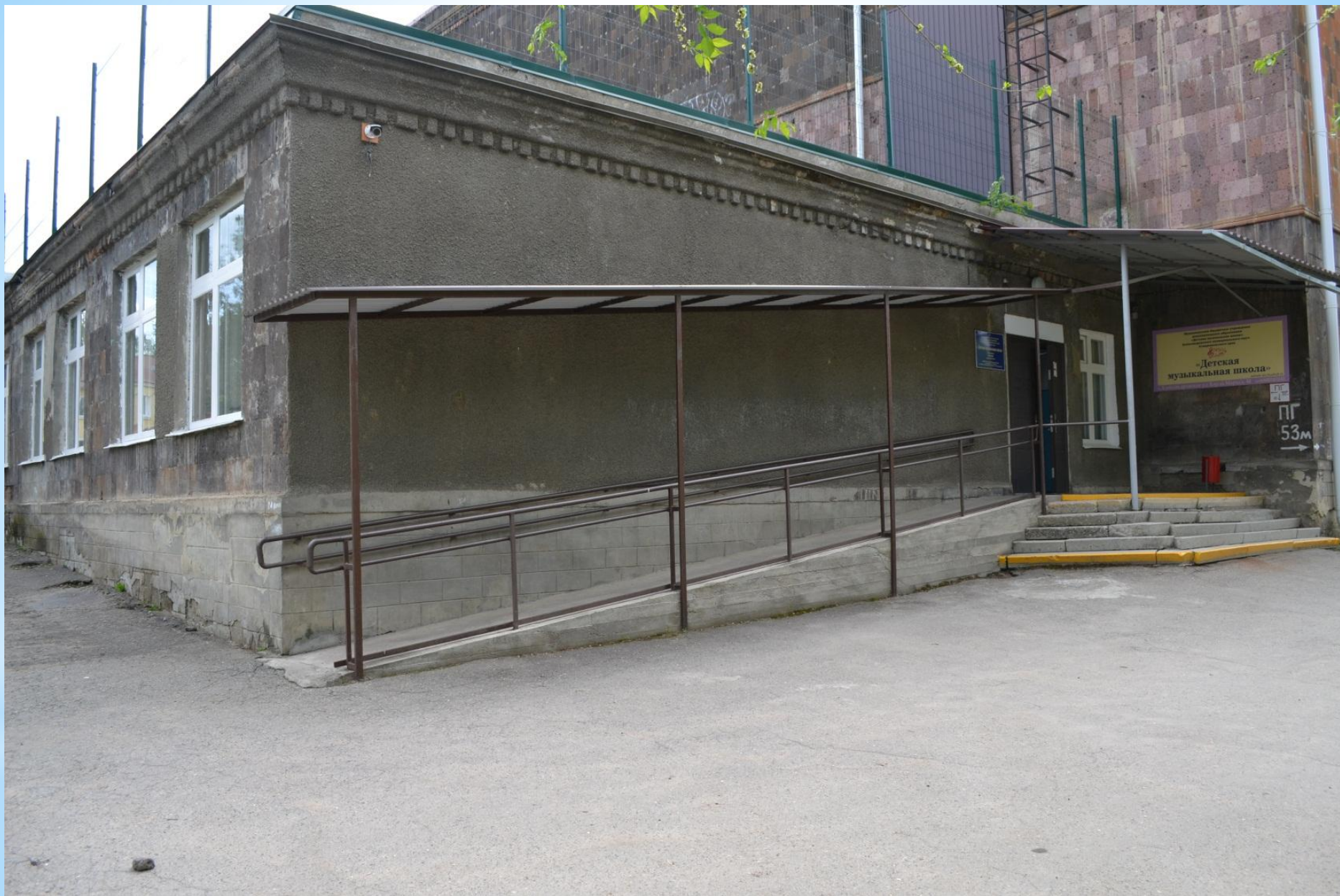
Здание детской музыкальной школы с. Александровского
