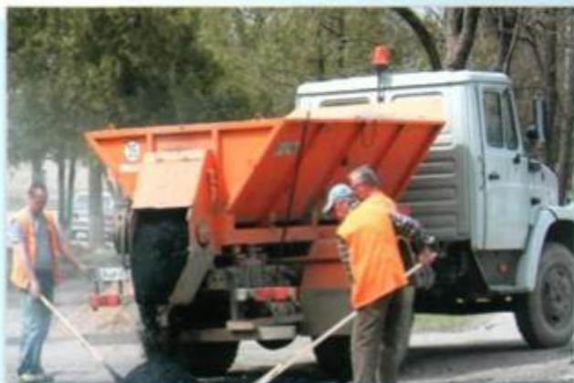
РЕМОНТ УЛИЦ ГОРОДА.
