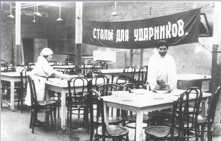
Столовая Ивановского меланжевого комбината, 1931 г.
