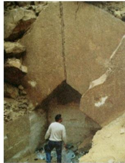
Фрагменты пирамиды Усеркафа в Саккара. Фотография С. Е. Кашницкого. Погребальная камера была перекрыта протоаркой – конструкцией на мощных попарно наклоненных друг к другу каменных блоках
