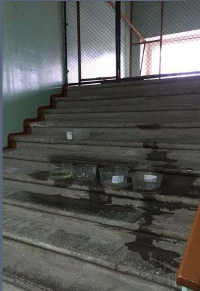
Корпус «В», 4 этаж
