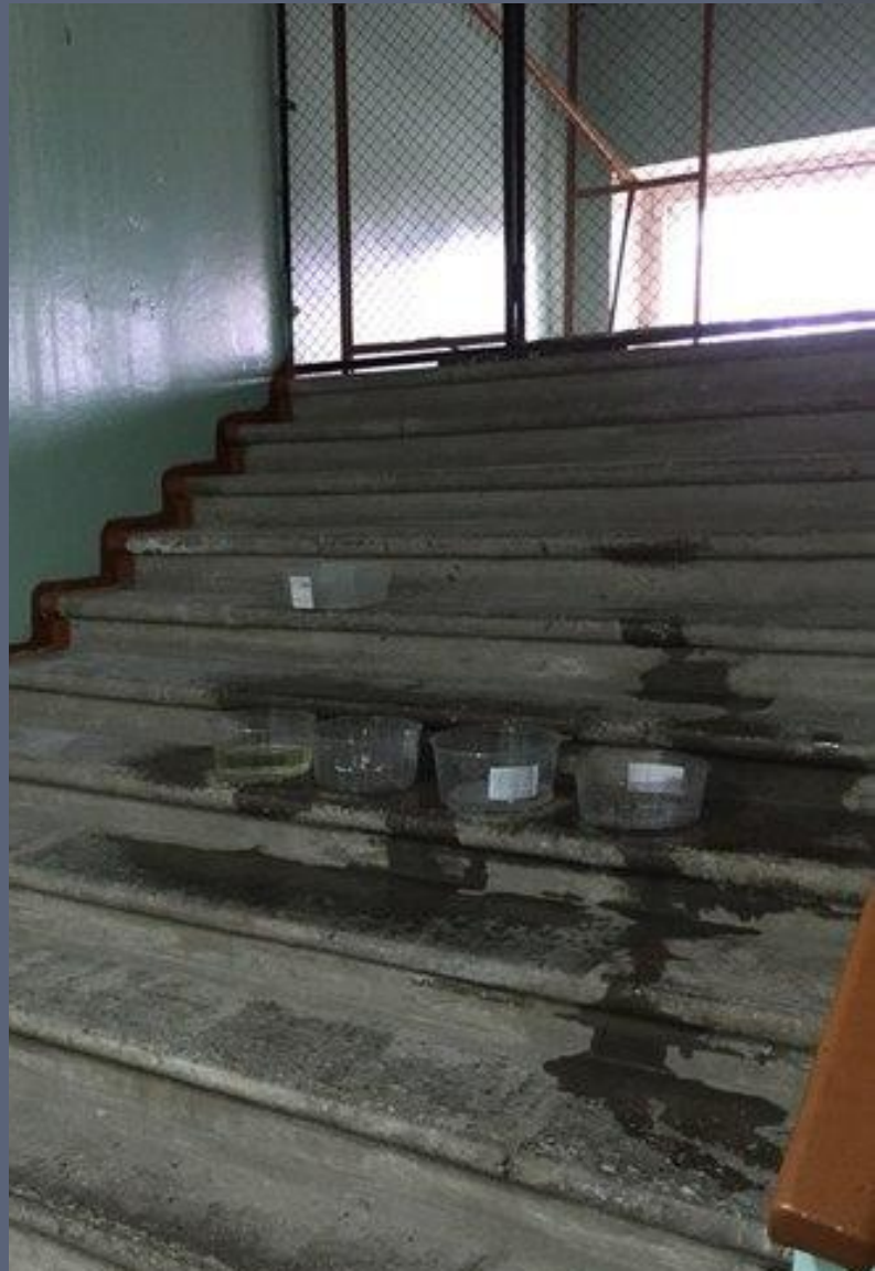
Корпус «В», 4 этаж
