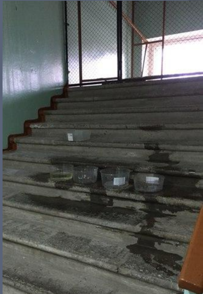
Корпус «В», 4 этаж
