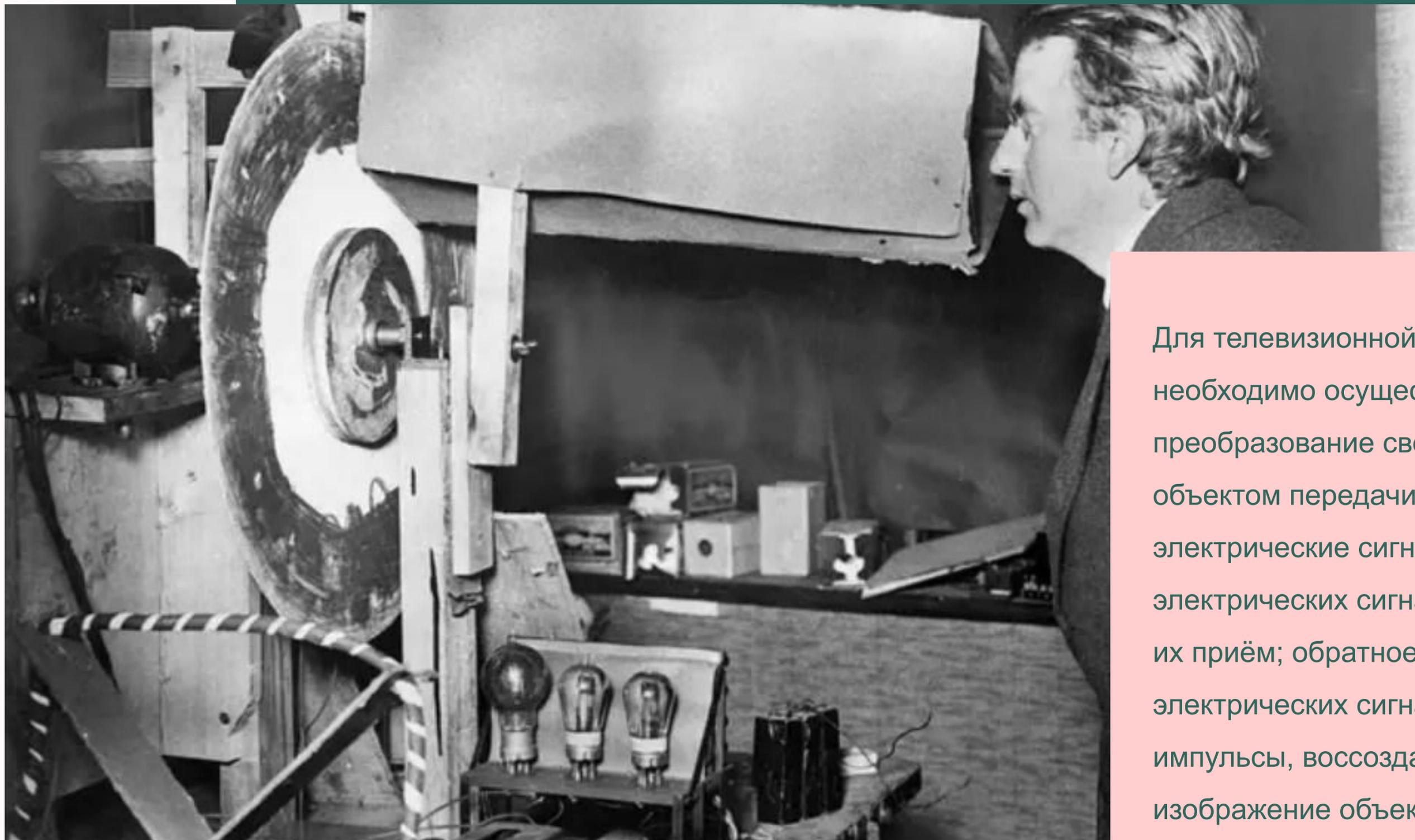
Для телевизионной передачи изображений необходимо осуществить 3 процесса: преобразование света, испускаемого объектом передачи или отражаемого им, в электрические сигналы; передачу электрических сигналов по каналам связи и их приём; обратное преобразование электрических сигналов в световые импульсы, воссоздающие оптическое изображение объекта. Страницы истории изобретения телевидения
