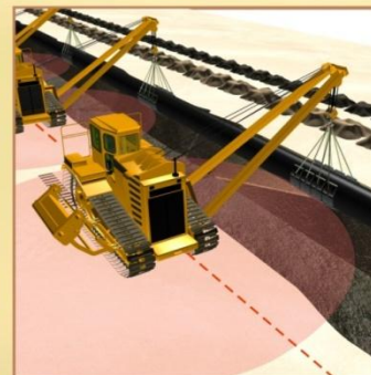
РАБОТА В ЗОНЕ ВОЗМОЖНОГО ОБРУШЕНИЯ ГРУНТА
