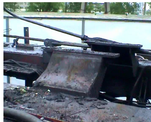
Узел технологического оборудования до очистки
