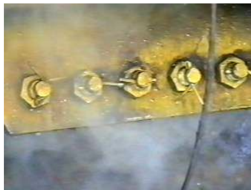
Узел крепления железнодорожной цистерны после очистки
