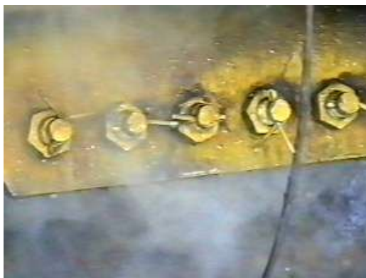
Узел крепления железнодорожной цистерны после очистки
