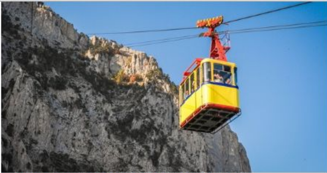
Канатная дорога к горе Ай-Петри (Крым) с самым большим безопорным пролетом в Европе (1670 м).
