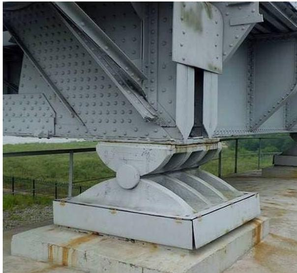
На рисунке - шарнирно-неподвижный опорный узел моста, состоящий из двух частей, нижняя часть – это гладкий шарнир на поставке, связанной с бетонной опорой моста.
