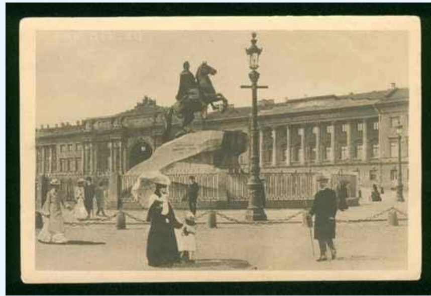
Здание Сената и Синода
