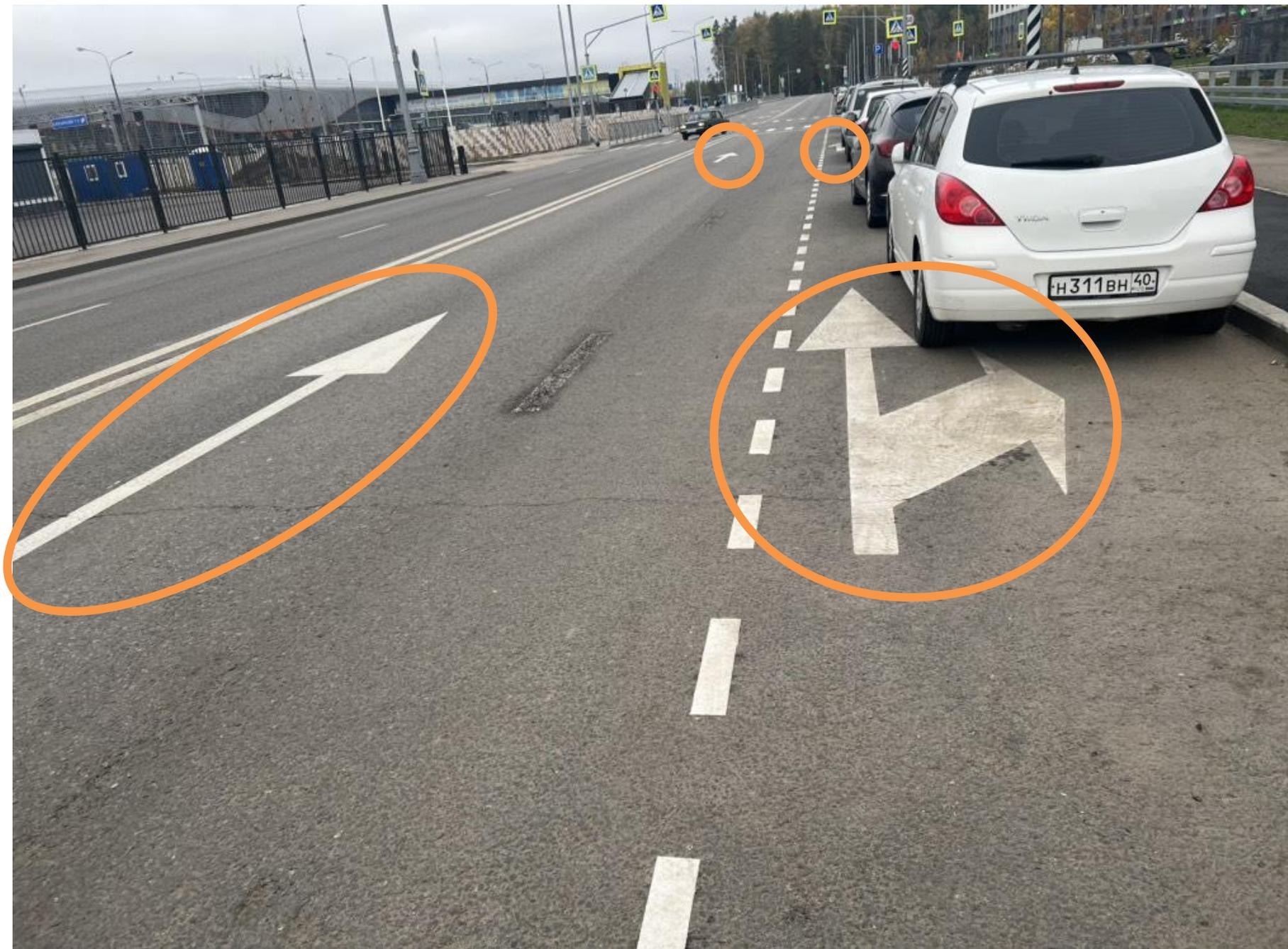
Демаркировать или лучше закрасить дорожную разметку 1.5, и 1.6 на всем протяжении проезда
