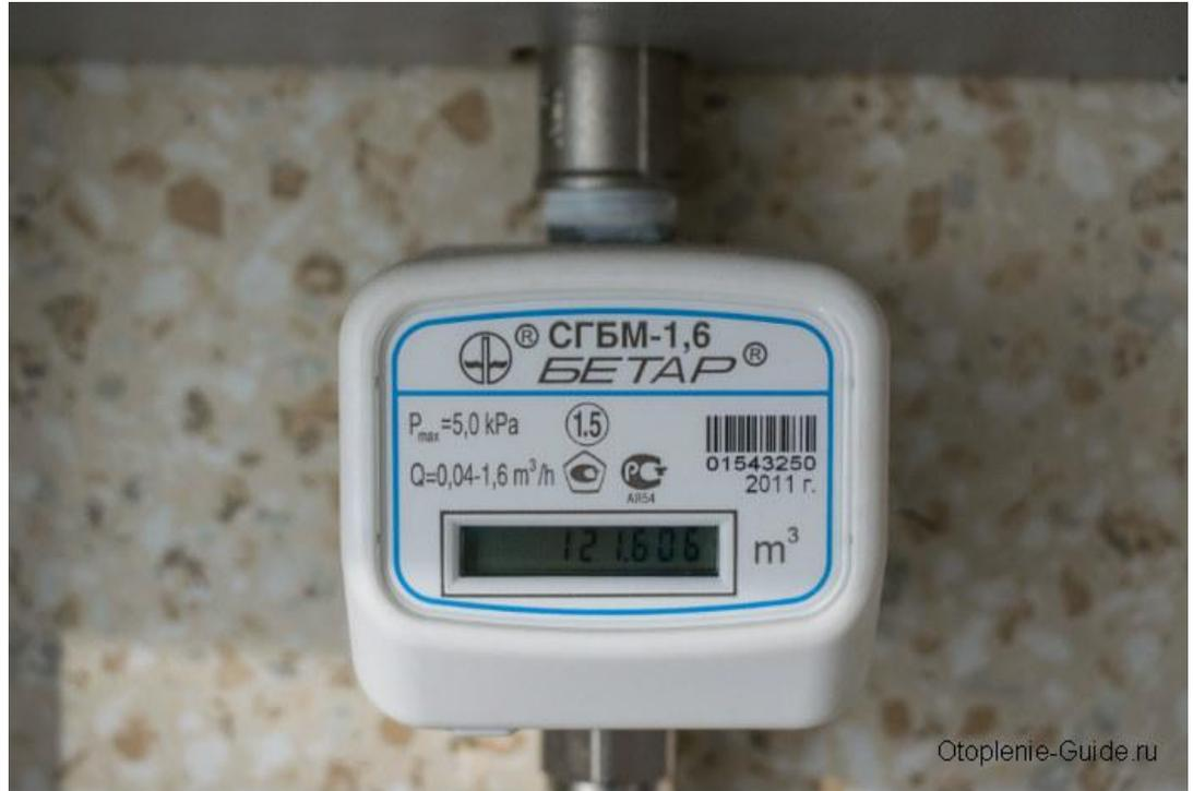
В последнее время всё большую распространённость стали завоёвывать электронные бытовые газовые счётчики. Они считаются газовыми приборами последнего поколения.
