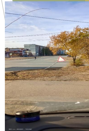
Правка стойки с ДЗ на перекрестке ул. Рокоссовского – пр. Фадеева
