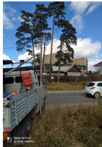
Установка стойки с ДЗ ул. Нерчинско-Заводская – ул. Кабанская
