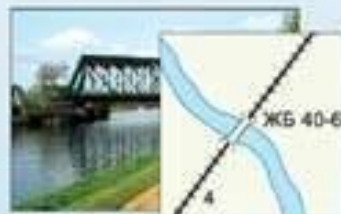
Железная дорога и железобетонный мост
