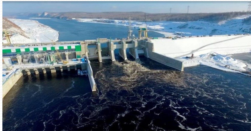
Нижнебурейская ГЭС (2017 г.) на реке Буряя
