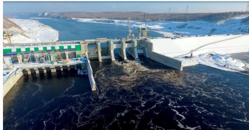
Нижнебурейская ГЭС (2017 г.) на реке Бурей
