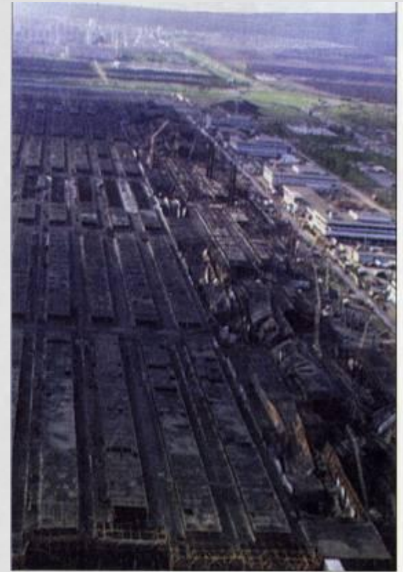
Последствия пожара на заводе двигателей АО «КамАЗ»
