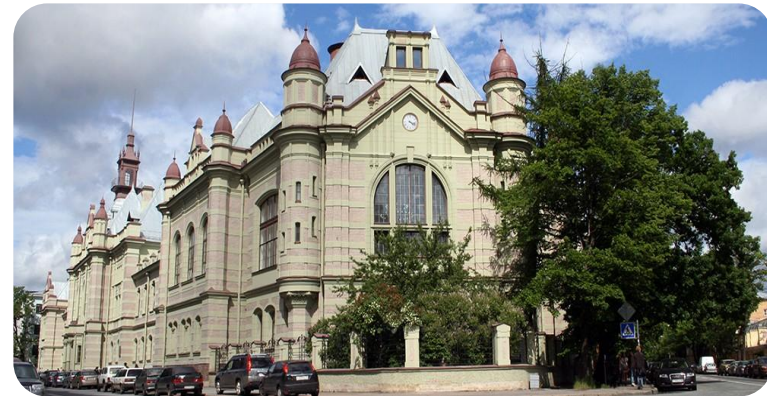
Санкт - Петербургский электротехнический университет
