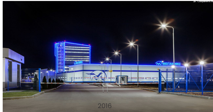
ООО «МЕГАМИКС ЦЕНТР» ЛИПЕЦКАЯ ОБЛ. С. ТЕРБУНЫ ПРОИЗВОДСТВО ПРЕМИКСОВ И ВИТАМИНА Е МОЩНОСТЬ 140000 ТОНН
