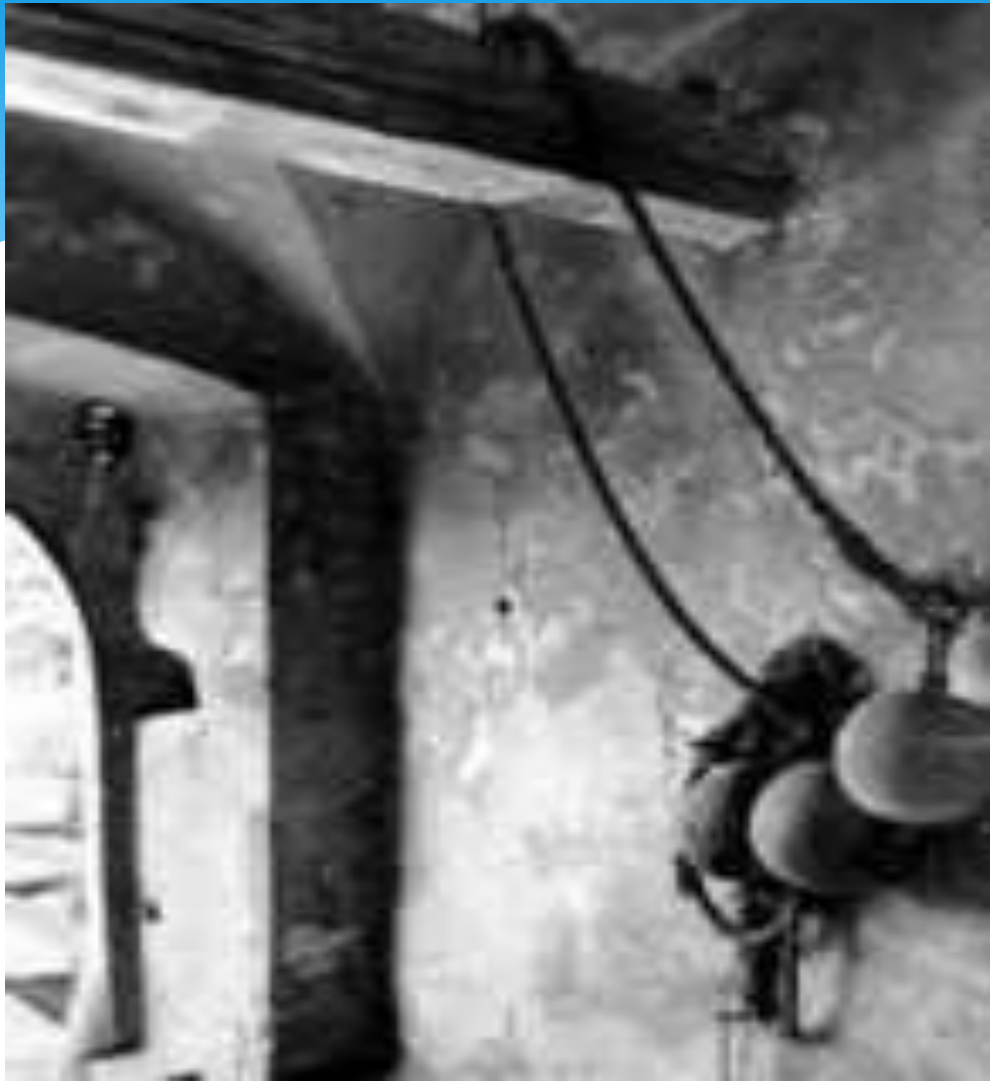
Противовесы на подъемнике ворот
