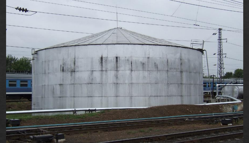
Старинный клёпаный резервуар Шухова на железнодорожной станции города Владимир, 2007
