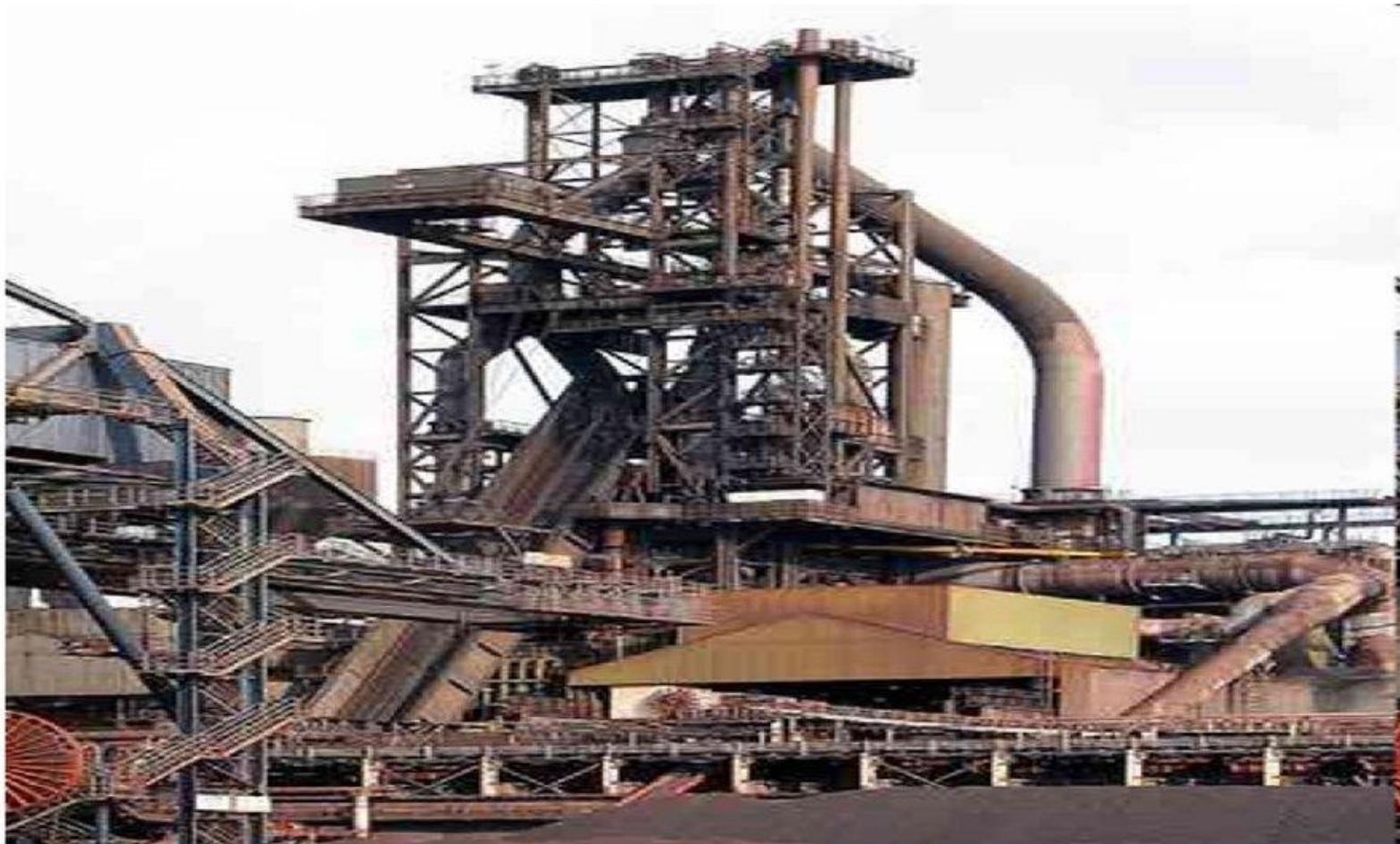
Чугун получают из руды *пирометаллургическим способом* в печах шахтного типа - *домнах*
