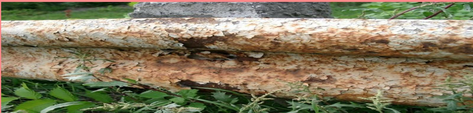
Для защиты изделий от коррозии применяют защитные покрытия, электрохимическую защиту и замедлители коррозии (ингибиторы), изменяющие состав коррозионной среды. В строительной практике чаще используют лакокрасочные и другие покрытия поверхности.
